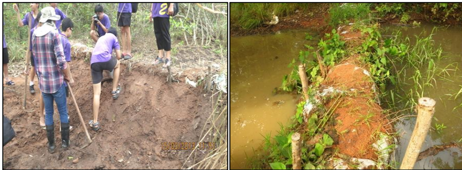
ภาพที่ 3.42 การทำฝายชะลอน้ำ
